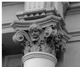
Пути на здании Городской думы. Коринфские колонны
